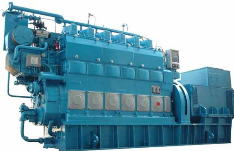
Unidad de generación eléctrica a base de motor recíprocante diesel 2 Mwe.
