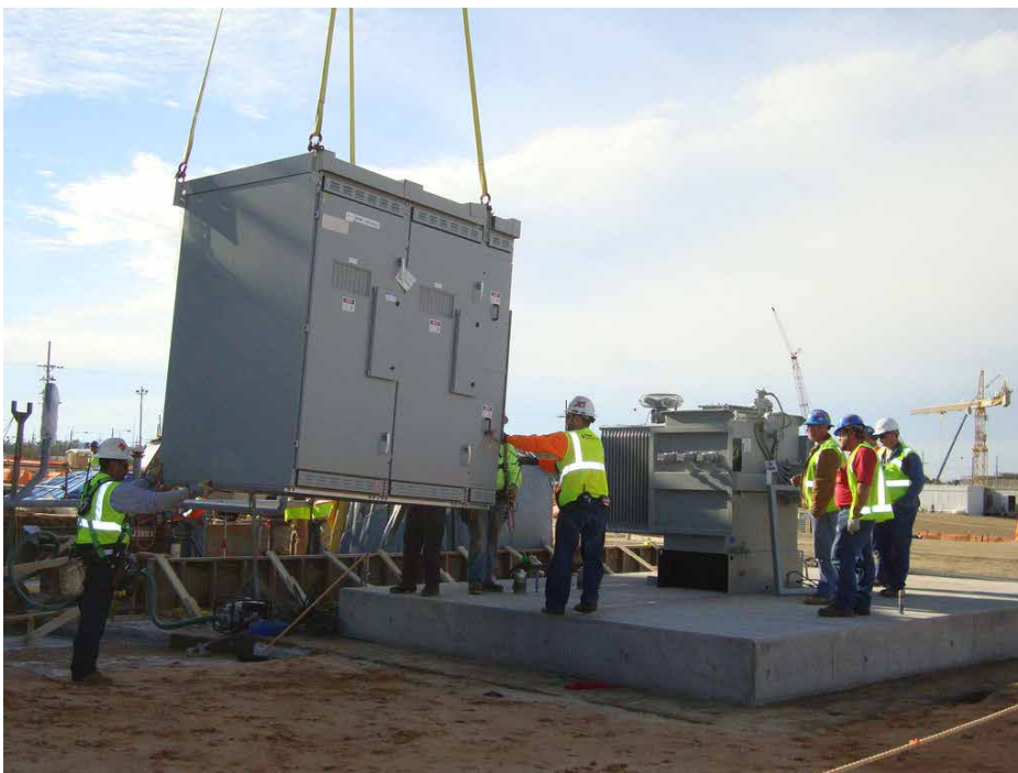
Montaje de subestación eléctrica 1,500 KWe.
